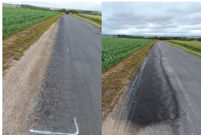
Nids de poules, portions de routes dégradées, reprises ponctuelles de rives de chaussée ont fait l’objet d’une campagne «d’enrobé projeté».
